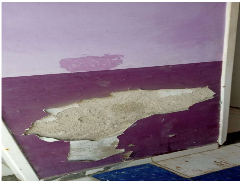
Remoção de Emboço
